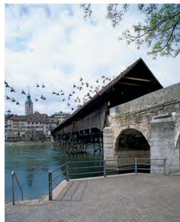
Olten, ponte «Aarebrücke» (1804)
