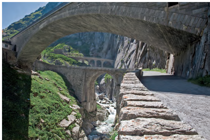
Il paesaggio del Ponte del Diavolo nella Schöllenen: sotto l'attuale ponte del 1958 scorre la vecchia strada cantonale con il ponte del 1830.
